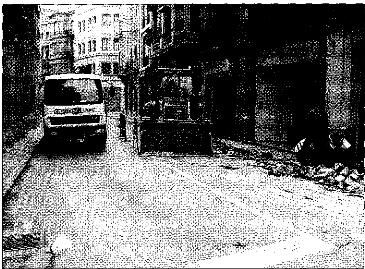
Comencen les restriccions al trànsit. El servei de Carreteres de la Generalitat va iniciar ahir les obres d'arranjament de l'avinguda de la Generalitat de Tortosa, una de les travesseres que traspasarà al municipi. FOTO: JOAN REVILLAS
